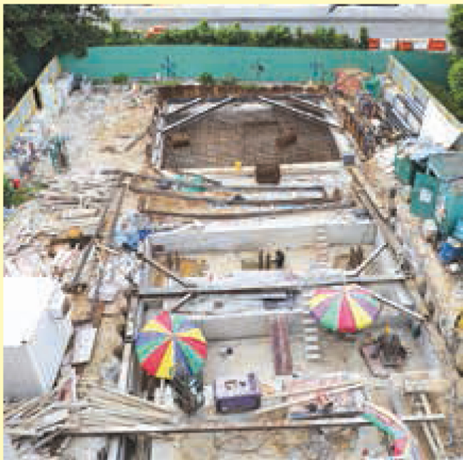
新教研大樓工地上的地基工程
